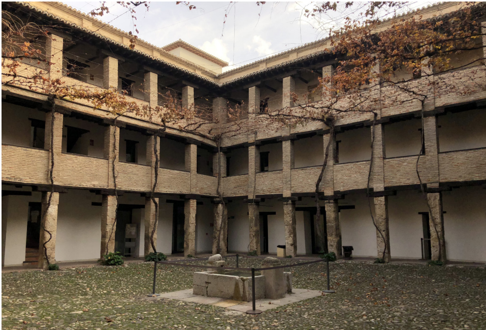
Figura 2 – Patio del funduq al-ḡadīd o Corral del Carbón de Granada. Fuente: elaboración propia.
